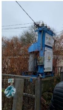
Рисунок 4 – Трансформаторная подстанция 10/0,4 кВ в с. Кокино
