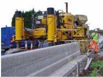
Устройство барьера на шоссе с помощью GOMACO Commander III в трехгусеничной конфигурации
