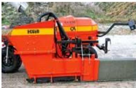
Устройство бортового камня с помощью CurbAppeal CLS600
