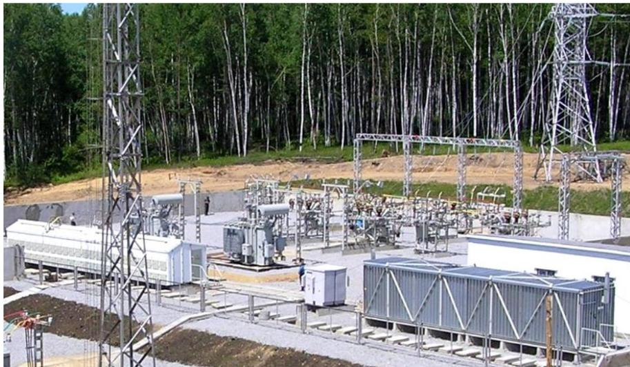
Рисунок 1.2 – Районная подстанция напряжением 35/10 кВ
