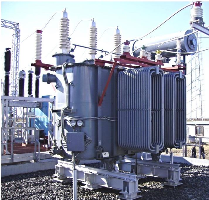
Рисунок 2.2 – Силовой трансформатор типа ТМН на ПС 110/10 кВ
