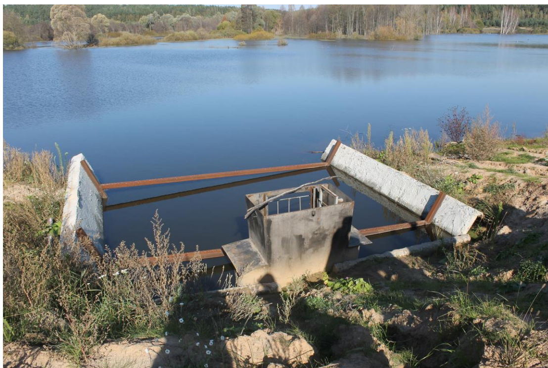
Шахтный водосброс на пруду оросительной системы д. Васьковичи
