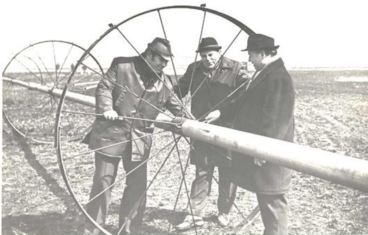
Монтаж ДКШ-64. Муравьев, Путило, Доронин 1979 г.
