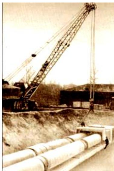
Рис. 3.8 - Монтаж трубопровода в полупроходных каналах
