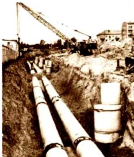
Рис. 3.4 - Укладка бесканального теплопровода
