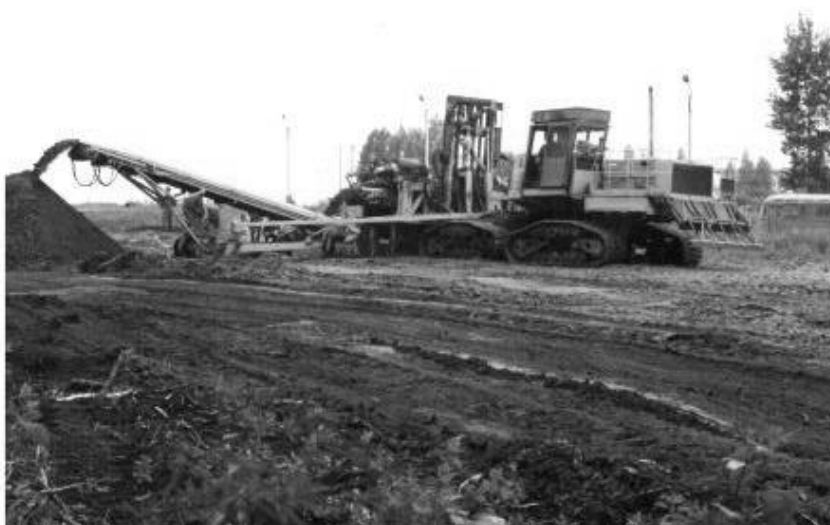
Рис.5.9. Проведение полевых испытаний зубьев с КЭП на траншейном экскаваторе ЭТЦ-3661
