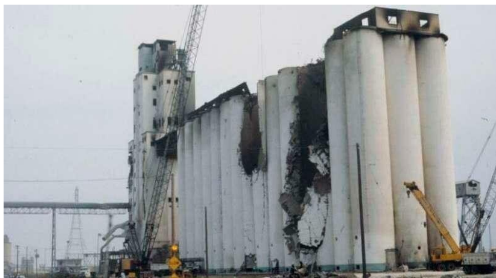
Рисунок 1 – Разрушенный пожаром и взрывами зерновой элеватор
