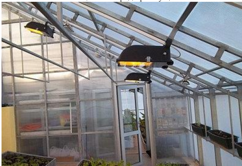
Рис. 5.4 Инфракрасные потолочные электрические обогреватели.
