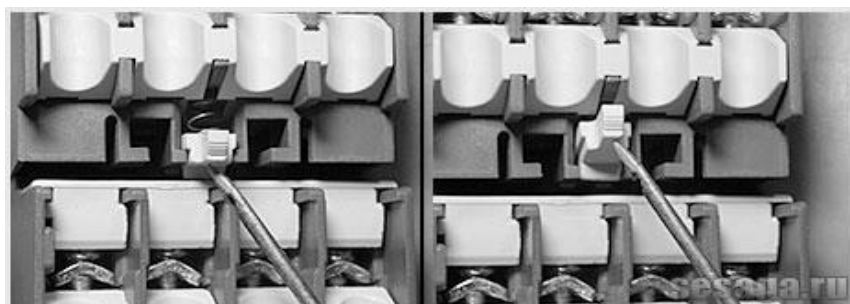
Рисунок 18 – Схема снятия приставки
