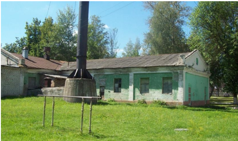
Рис.19. Здание 4 – санпропускник и труба котельной. Фото авторов
