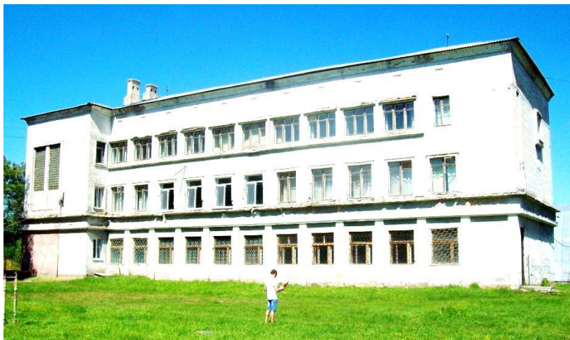
Рис. 13. Здание 1а – казарма для военнопленных. Фото авторов
