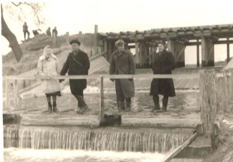
Рис. 4. В Кокино строится гидроэлектростанция. В центре инженер Рустецкий и военнопленный, электрик Хельмут Хакер (в шинели). 1945 г.
