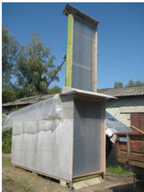
Рисунок 8.4 – Общий вид секции зернохранилища со встроенной гелиосушильной системой
