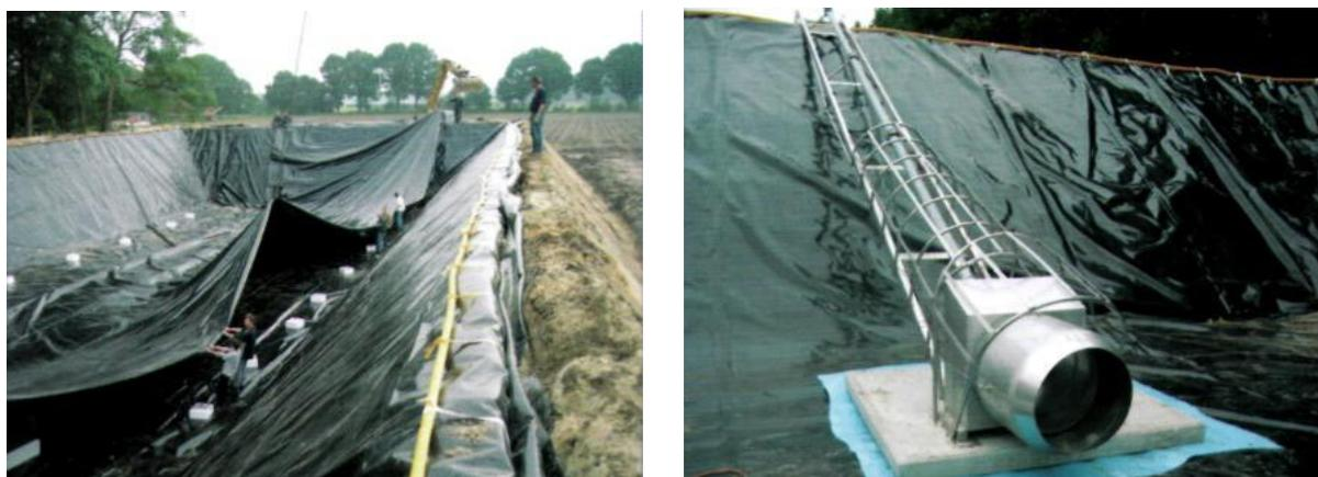
Рис. 1.6. Вид навозной лагуны и мешалки
