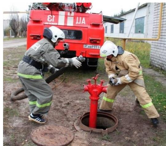
Рисунок 2.1 - Проверка пожарного гидранта
