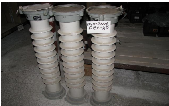
Рис76.Разрядник PBC-35.
