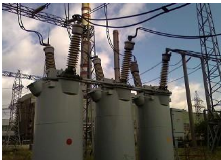
Рис 68. Масляный выключатель
