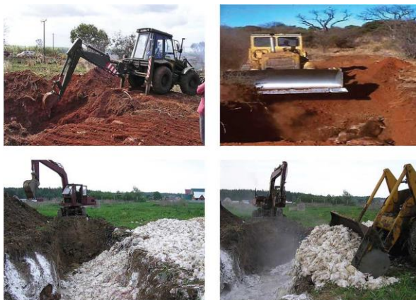
Рис. 18. Тяжелая землеройная техника, устройство и заполнение ямы для захоронения
