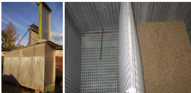
Рисунок 10 – Общий вид зернохранилища со встроенной гелиосистемой
