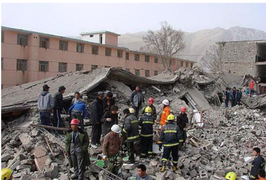
Рисунок 1.2 - Аварийно-спасательные работы при землетрясении
