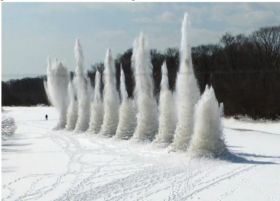
Рисунок 3.3 - Взрывные работы по ликвидации затора
