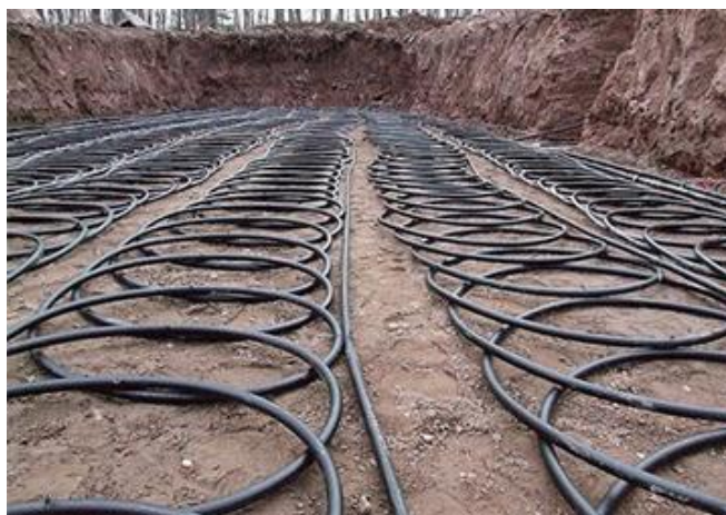
Рисунок 6.5. Горизонтальный коллектор теплового насоса
