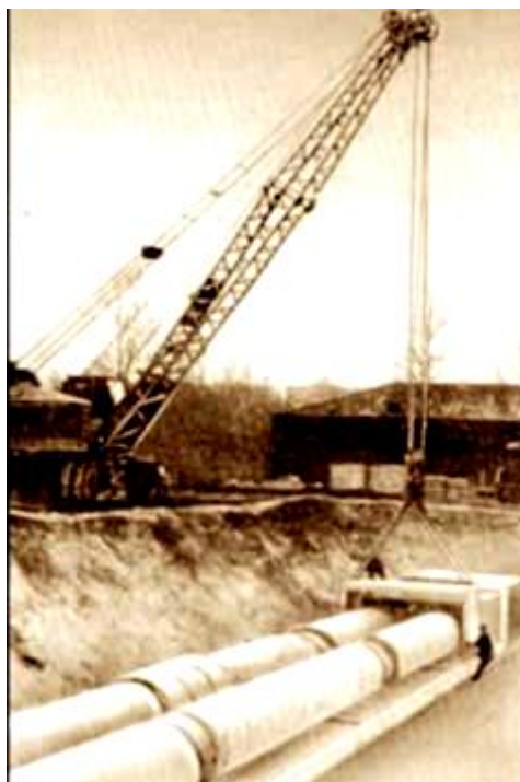
Рис 4.8. Монтаж трубопровода в полупроходных каналах
