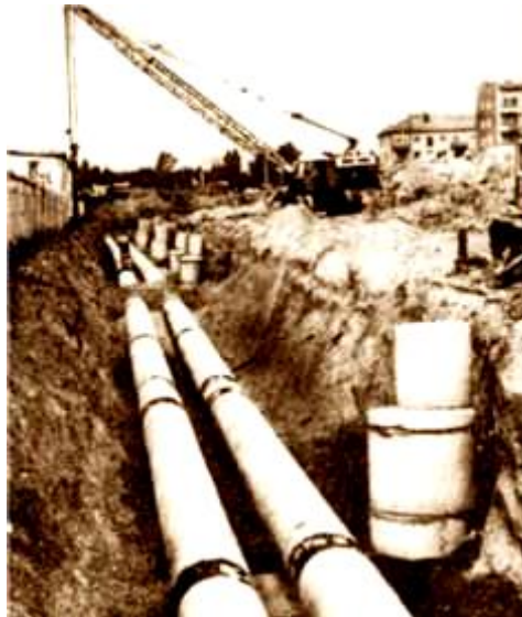
Рис. 4.4. Укладка бесканального теплопровода.
