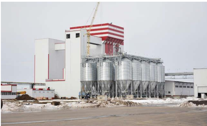
Рис. 47. Комбикормовый завод, построенный в рамках проекта «Брянский бройлер» в Выгоничском районе
