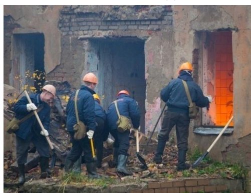
Рисунок 3.2 – Инженерная разведка в зоне ЧС
