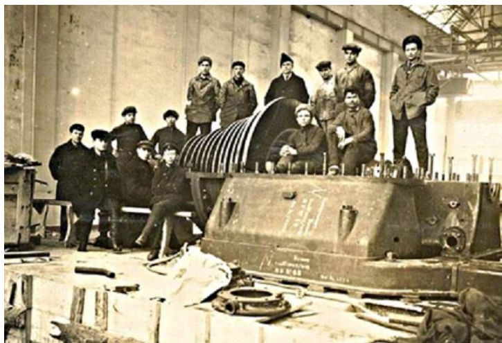
Рисунко 2 - Брянская ГРЭС 1929 монтаж первой турбины
